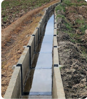
콘크리트 수로관 이음부 및 균열 누수 방지
