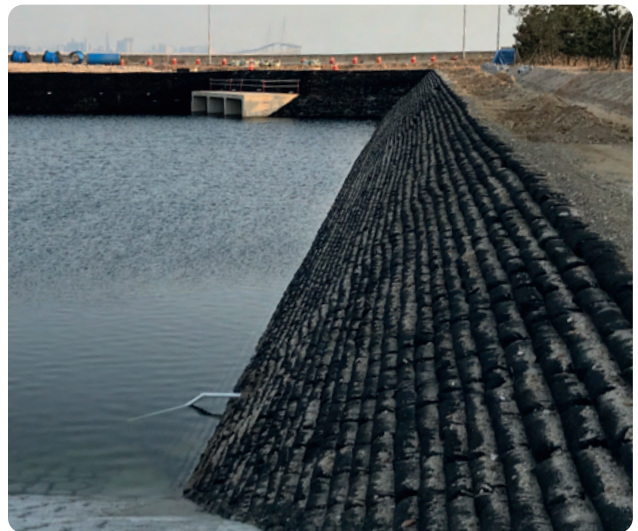
방조제 / 저수지 제방 등 내·외측 경사면 보강
