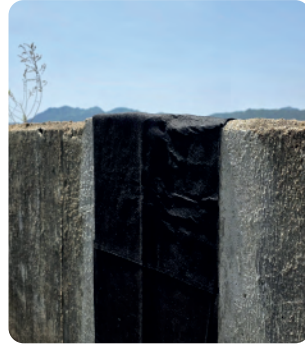
건물 외벽 균열 및 이격 누수 방지
