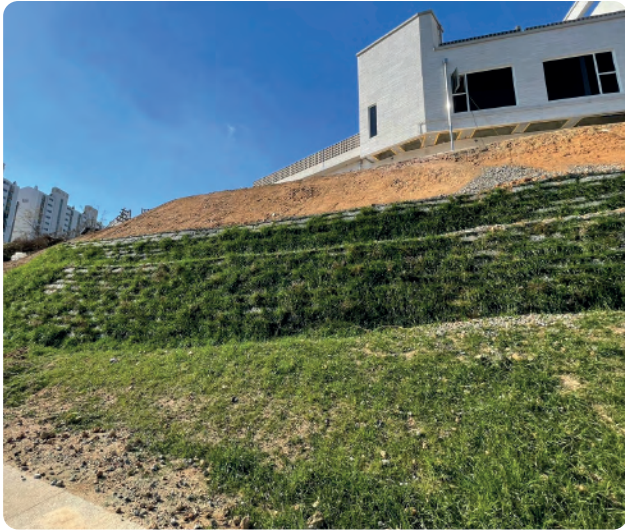
주변 환경과 조화로운 법면 녹화가 요구되는 옹벽 축조
