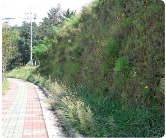
도로 사면 환경친화적 옹벽 축조
