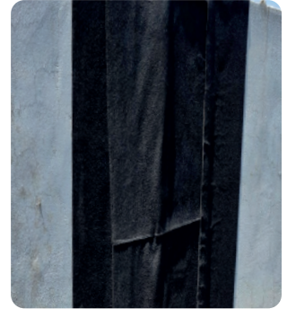
기타 콘크리트 표면 긴급 보수
