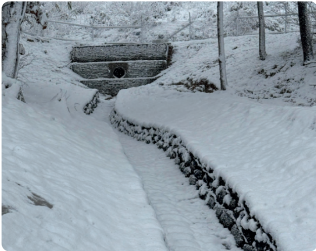
기온 변화에 의한 팽창/수축에도 수로의 균열 및 파손 없음
