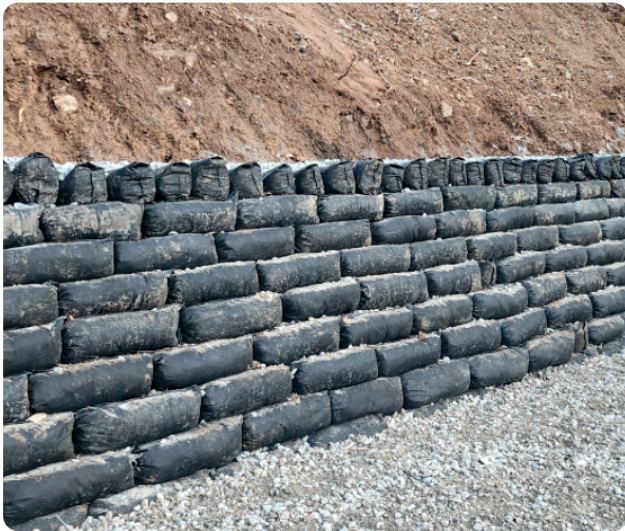
절토 및 성토면 안정 및 보호 옹벽 축조
